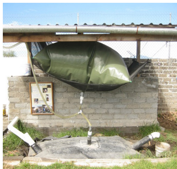
So sieht der BioBolsa-Gasspeicher aus
