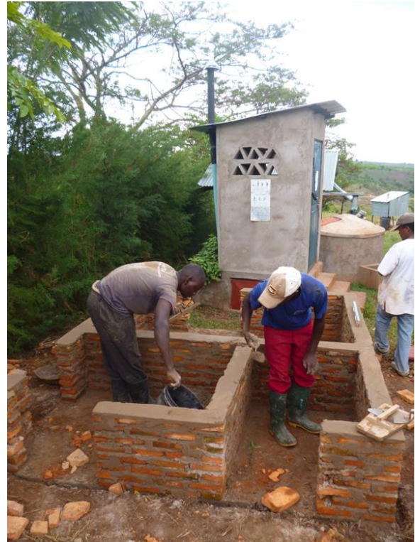
Bauteam beim Bau der zweiten Toilette. Im Hintergrund sieht man die erste Toilette aus der Pilotphase.
