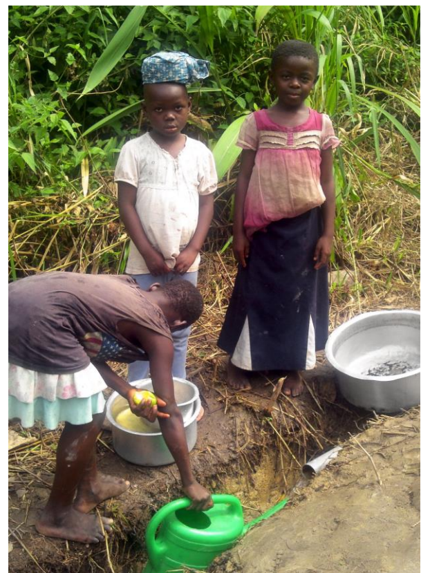
Schon während des Verlegens werden die Wasserleitungen genutzt
